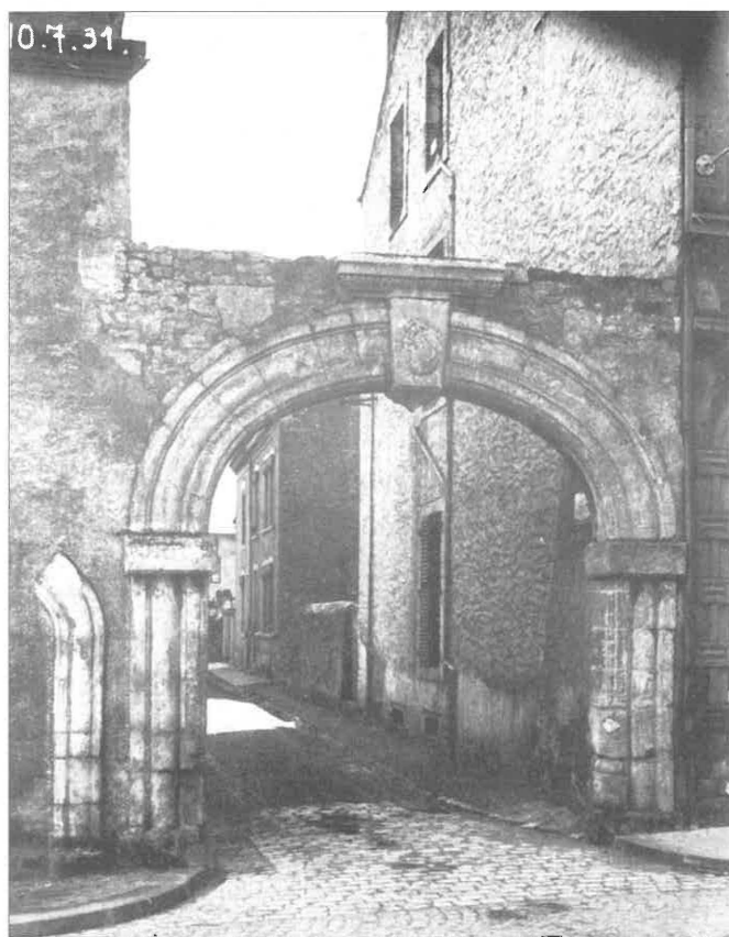
Klosterportal: erbaut 1636, abgetragen 1931
