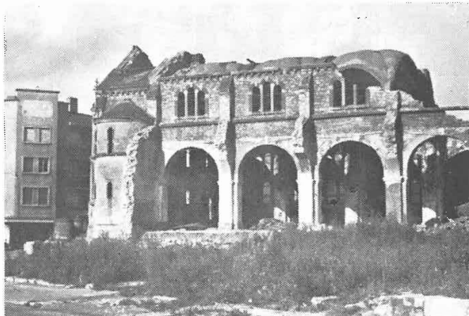
Die St. Joseph-Kirche wurde während des Zweiten Weltkrieges am 9. August 1944 zerstört.
